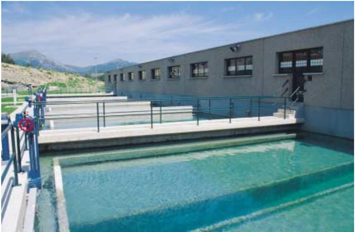
La estación cuenta con seis filtros de arena. Cada uno de ellos tiene una superficie de 84 m<sup>2</sup> y está provisto de 2.800 boquillas a través de las cuales sale el agua filtrada hacia el depósito. El caudal de agua filtrada se regula mediante seis válvulas de control.
