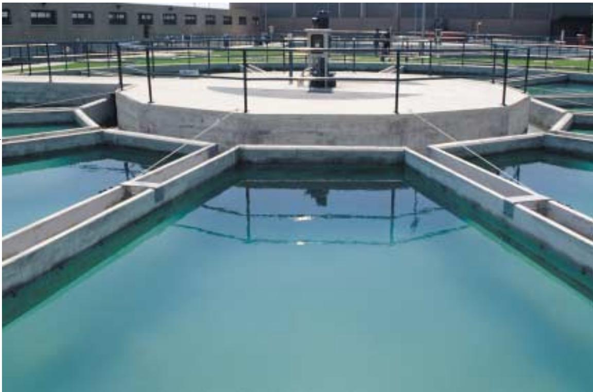
La decantación se lleva a cabo en dos decantadores circulares de 26 m de diámetro y 7,33 m de altura, en los que el agua permanece por espacio de dos horas aproximadamente.
